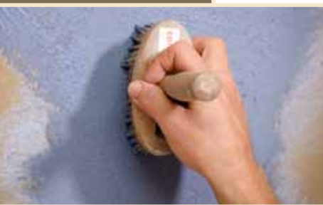
Lehm-Streichputz im Kreuzschlag auftragen
