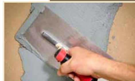
Edelputz mit der Edelstahl-Glättkelle auftragen
