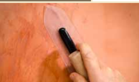
conlino Kaseingrundierung mit der japanischen Glättekelle aus Kunststoff verteilen
