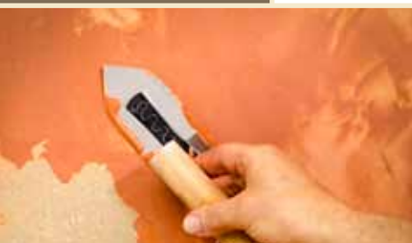
conlino Kaseingrundierung mit der japanischen Glättekelle aus Kunststoff aufspachteln
